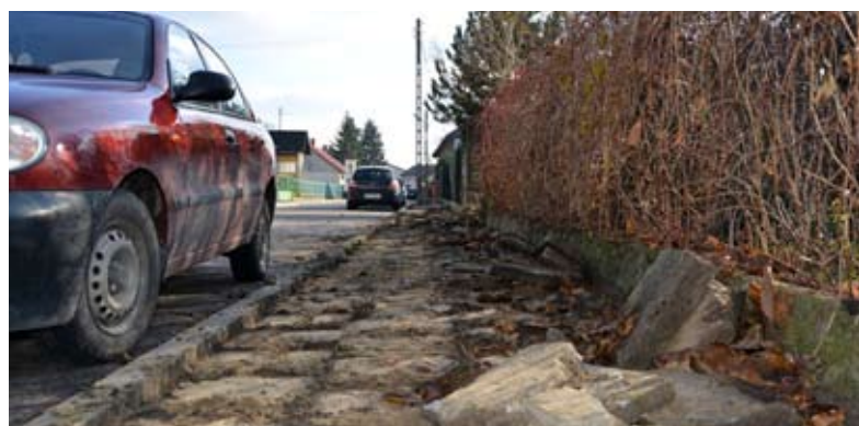
Remont chodnika przy ul. Strzeleckiej
